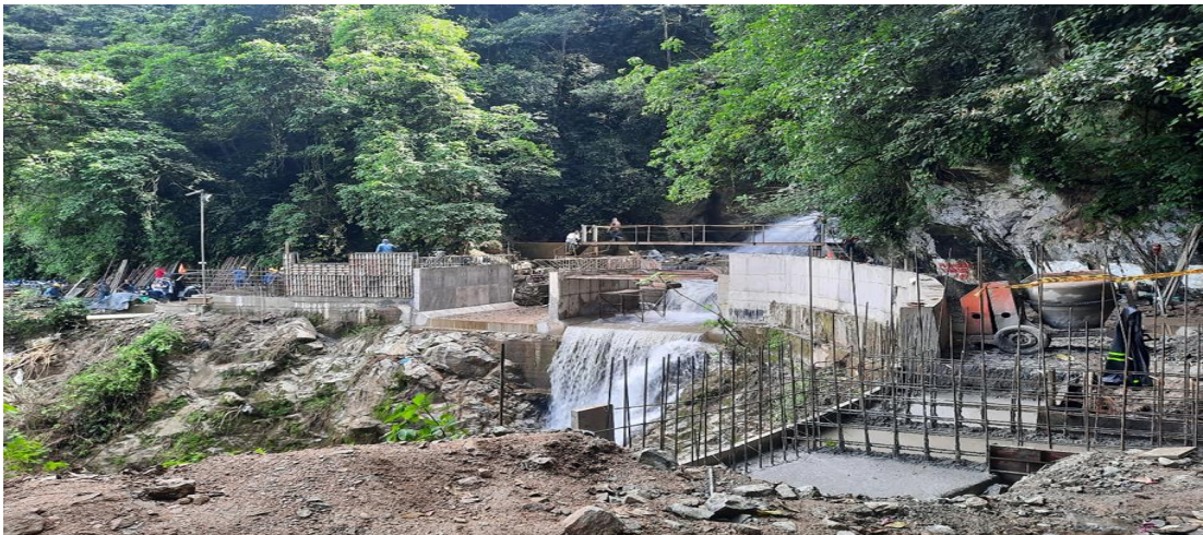
Panoramica del Box coulvert y obras complementarias – bocatoma- del k2+440 al K2+500 tramo 1.
