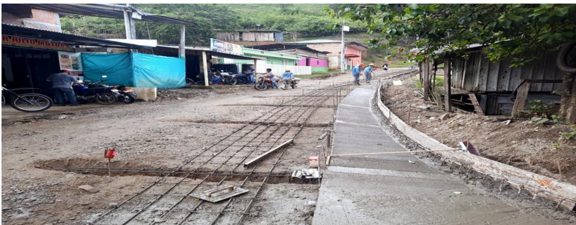
Construcción Placa huella tramo k0+000 al k0+038, carril derecho
